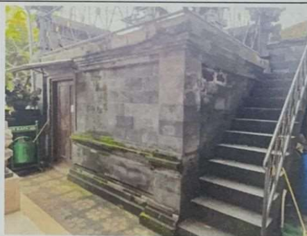
KONDISI AREA LANTAI 1
