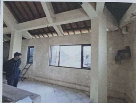
KONDISI AREA LANTAI 2
