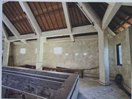
KONDISI AREA LANTAI 2
