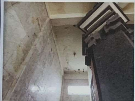
KONDISI AREA LANTAI 1
