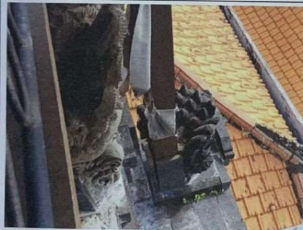
KONDISI AREA BALE KULKUL
