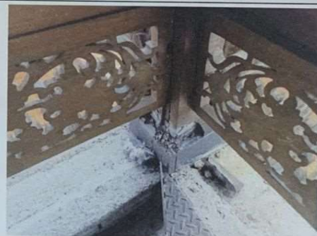
KONDISI AREA BALE KULKUL
