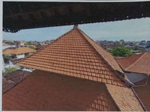
KONDISI ATAP BANGUNAN
