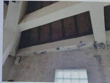
KONDISI AREA LANTAI 2
