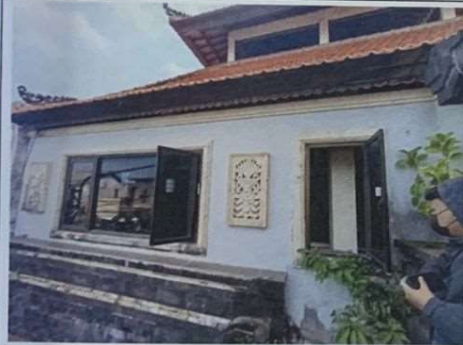
KONDISI AREA LANTAI 2
