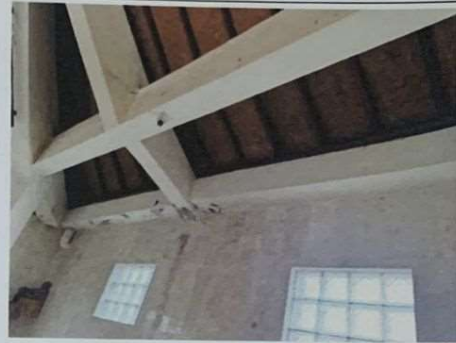
KONDISI AREA LANTAI 2
