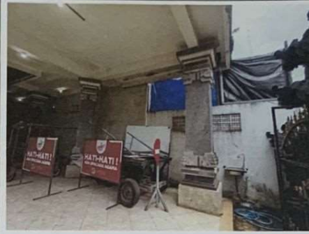
KONDISI AREA LANTAI 1
