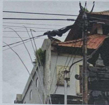
KONDISI ATAP BANGUNAN
