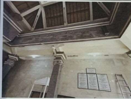
KONDISI AREA LANTAI 1
