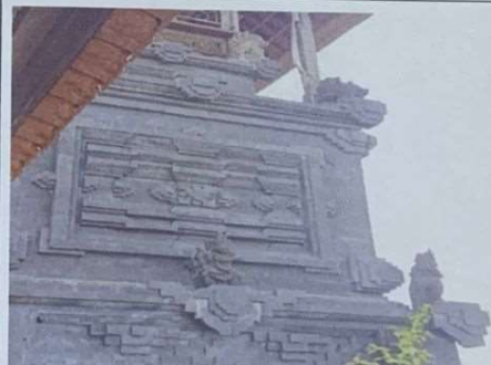
KONDISI AREA BALE KULKUL
