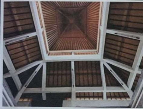
KONDISI ATAP BANGUNAN
