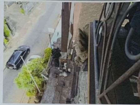
KONDISI AREA BALE KULKUL
