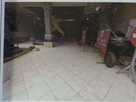
KONDISI AREA LANTAI 1
