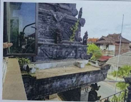
KONDISI AREA BALE KULKUL
