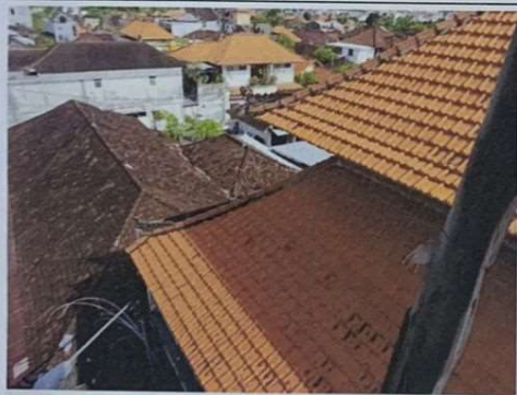
KONDISI ATAP BANGUNAN
