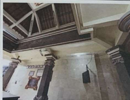
KONDISI AREA LANTAI 1
