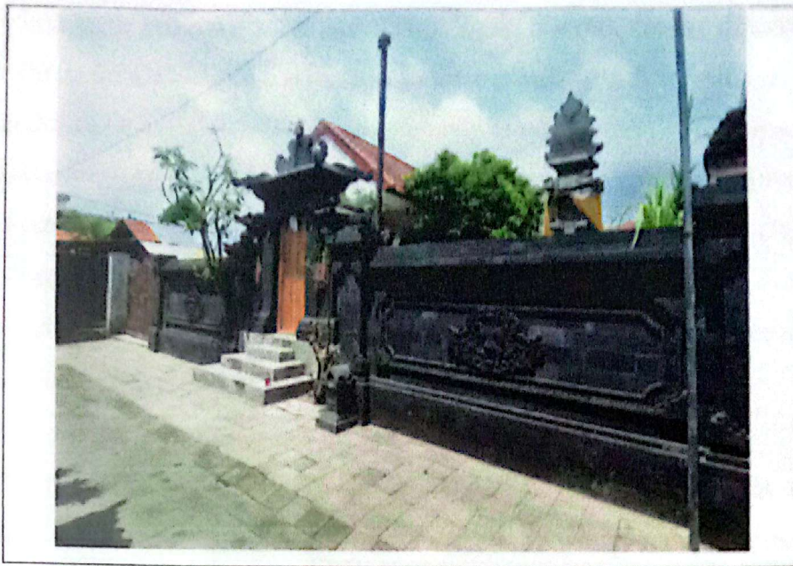
Gambar 3.4 Pintu Gerbang dan Tembok Penyengker Wantilan Pengempon Pemrajan Bedji.
