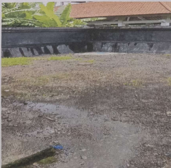
Lokasi Bangunan Dapur dan Kamar Mandi
