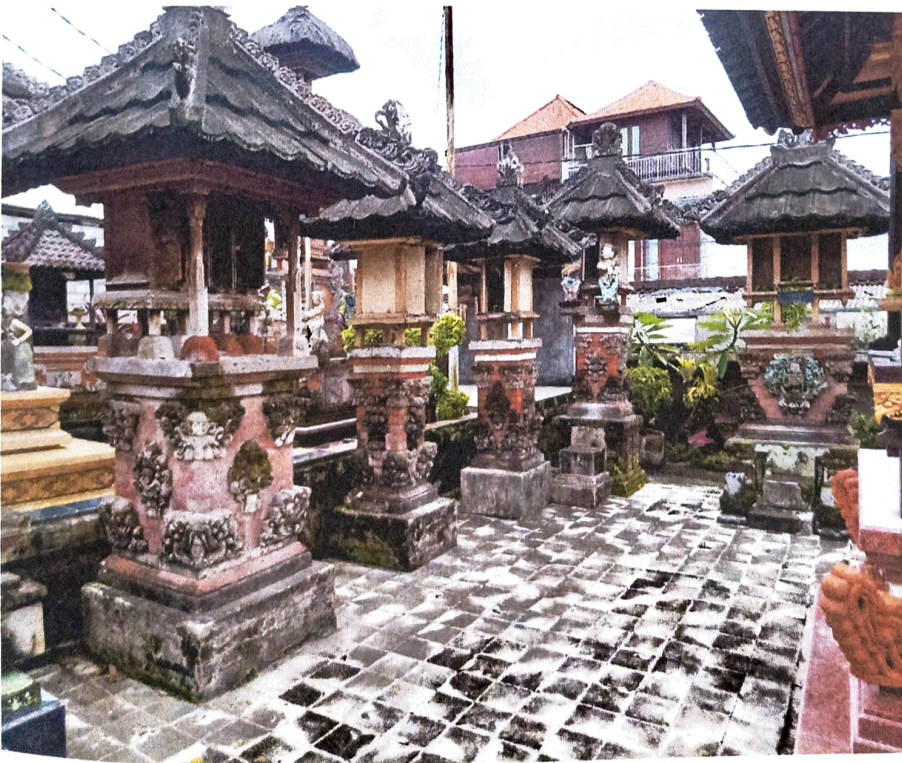
5 pelinggih yang akan diperbaiki
