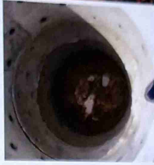
Sumur Resapan Buis Beton Dia. 70cm
