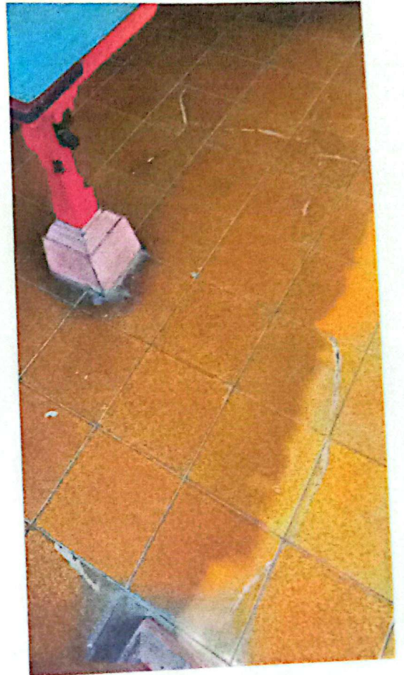
Gambar 02. Kondisi Lantai saat ini yang semakin turun Dok. 23/04/2025
