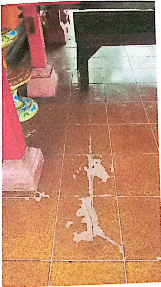
Gambar 02. Kondisi Lantai saat ini yang semakin turun Dok. 23/04/2025
