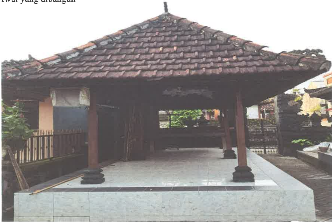
Foto Awal yang dibangun
