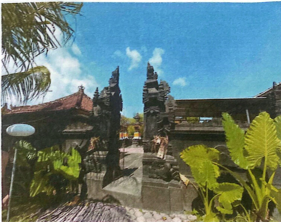
Tembok yang akan bongkar dan di pindaht0kan
