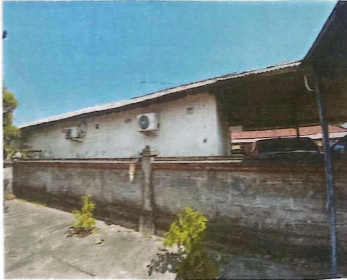
Tembok yang akan di perbaiki sebagai pintu masuk dan keluar
